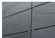
Sichtbare Klammertechnik für großformatige Fassaden
